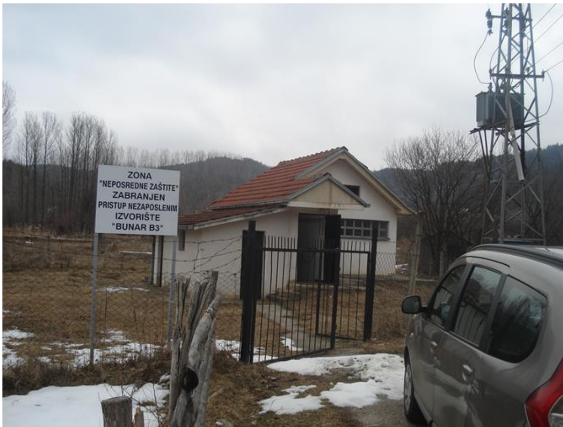
Pumpno postrojenje Bunara B-3 „Sred polje“.
